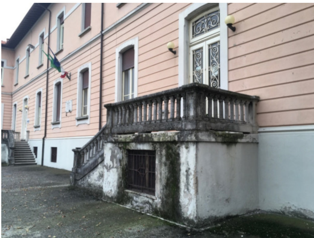
Figura 35 – Degrado della scala esterna 01
