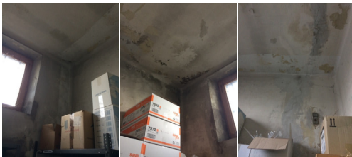
Figura 8 – Degrado nella zona interne delle scale
