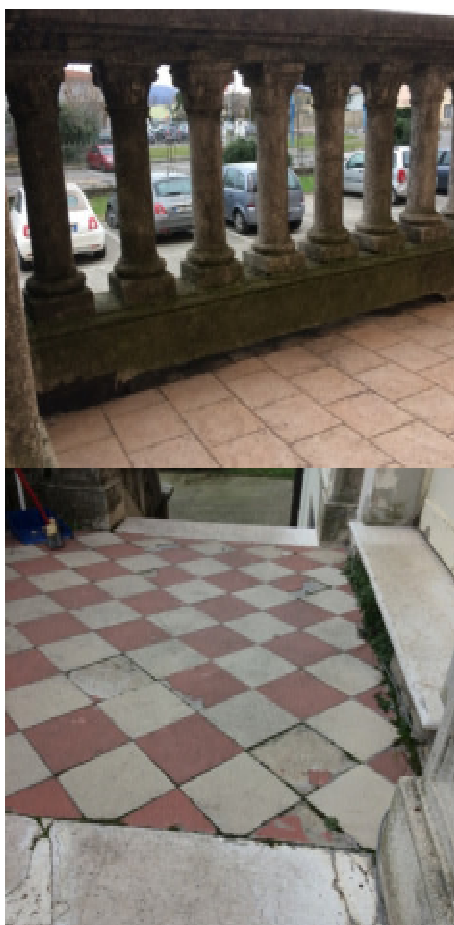
Figura 37 – Degrado generale delle scale esterne e visione della pavimentazione rimaneggiata (sopra a destra) e della pavimentazione originale (sotto a destra)
