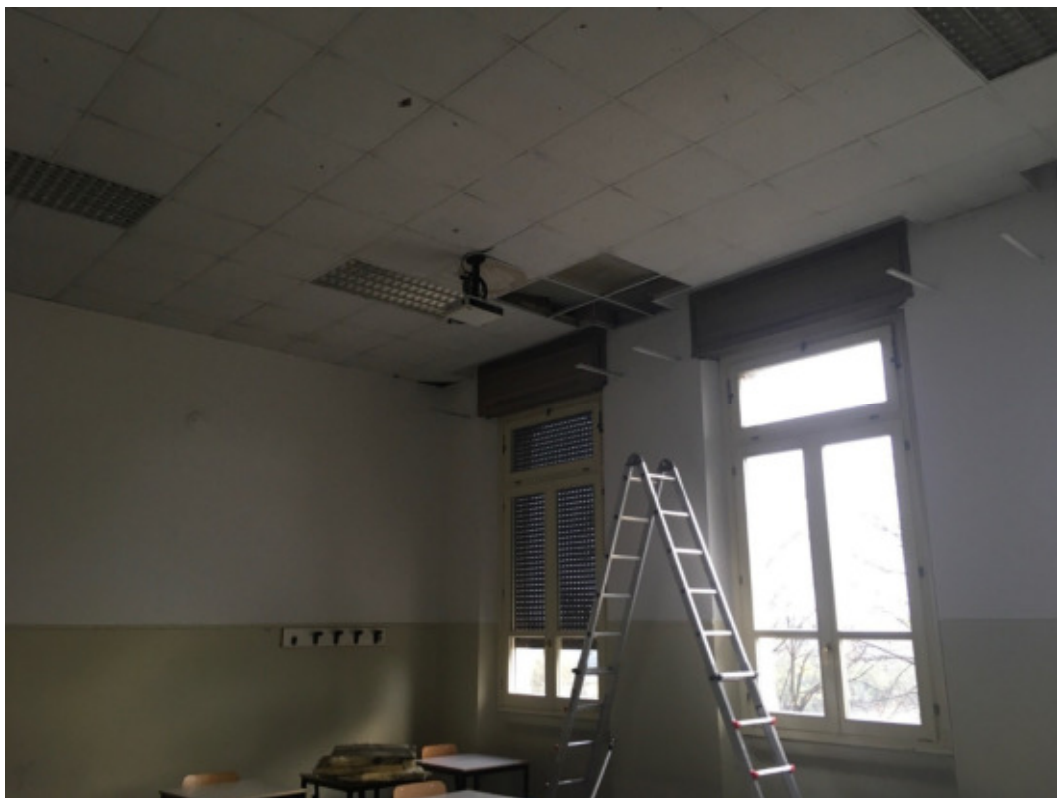
Figura 44 – Infiltrazioni di acqua al piano primo
