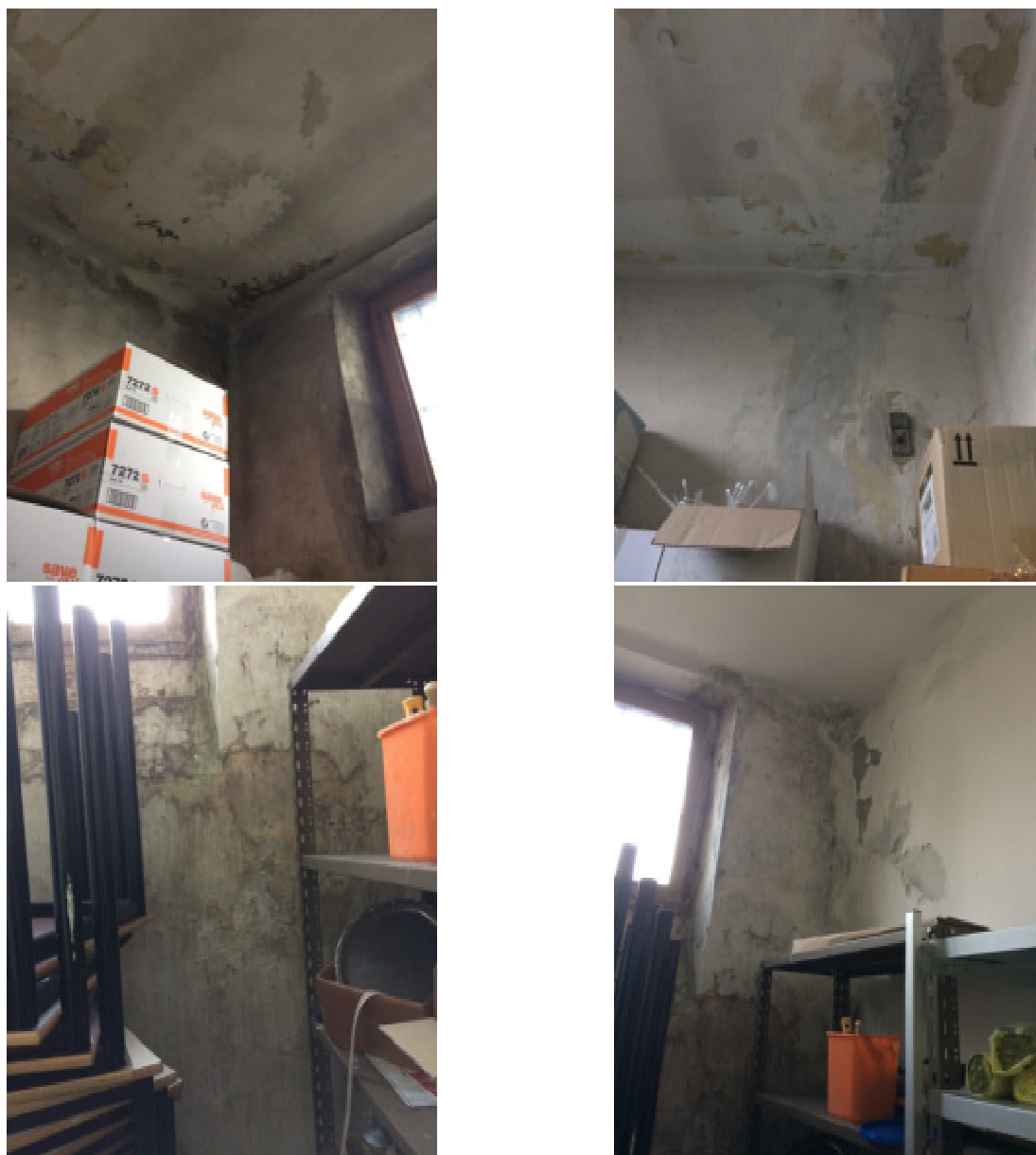
Figura 21 – Degrado interno alla scala esterna 02
