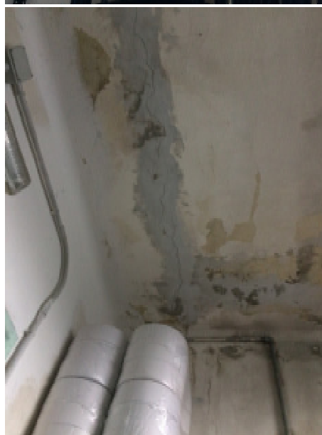
Figura 20 – Degrado interno alla scala esterna 02
