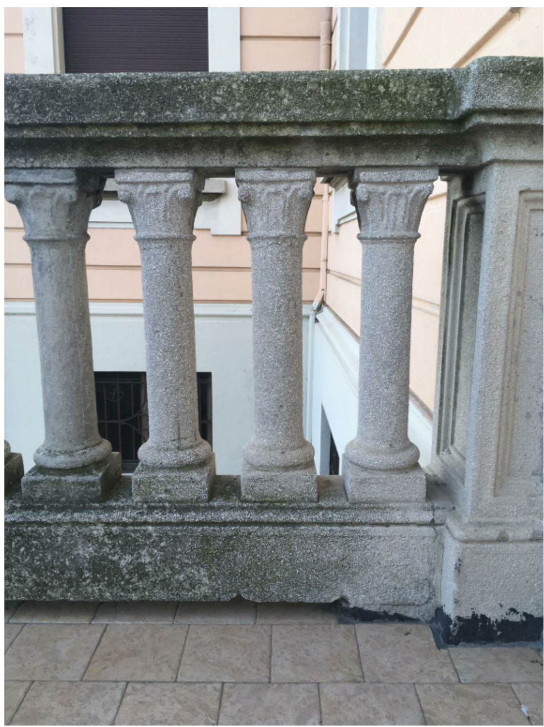
Dettagli balaustra allo stato di fatto e pavimentazioni da sostituire
