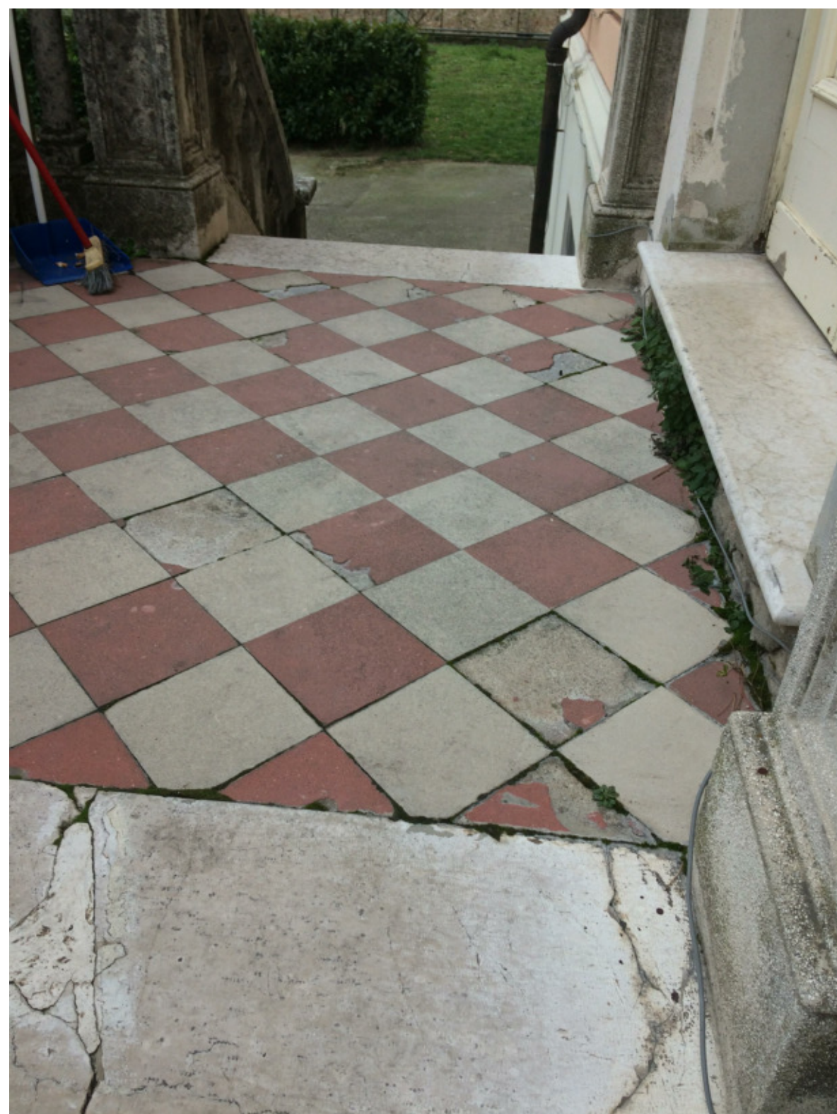
Pavimentazione a quadrotti bianchi e rossi tipo cementine su scala lato est da risanare. Pavimentazione da replicare anche sui pinerottoli delle altre scale
