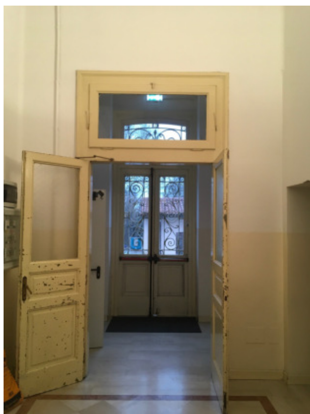
Figura 9 – Stato di conservazione dei serramenti interni principali
