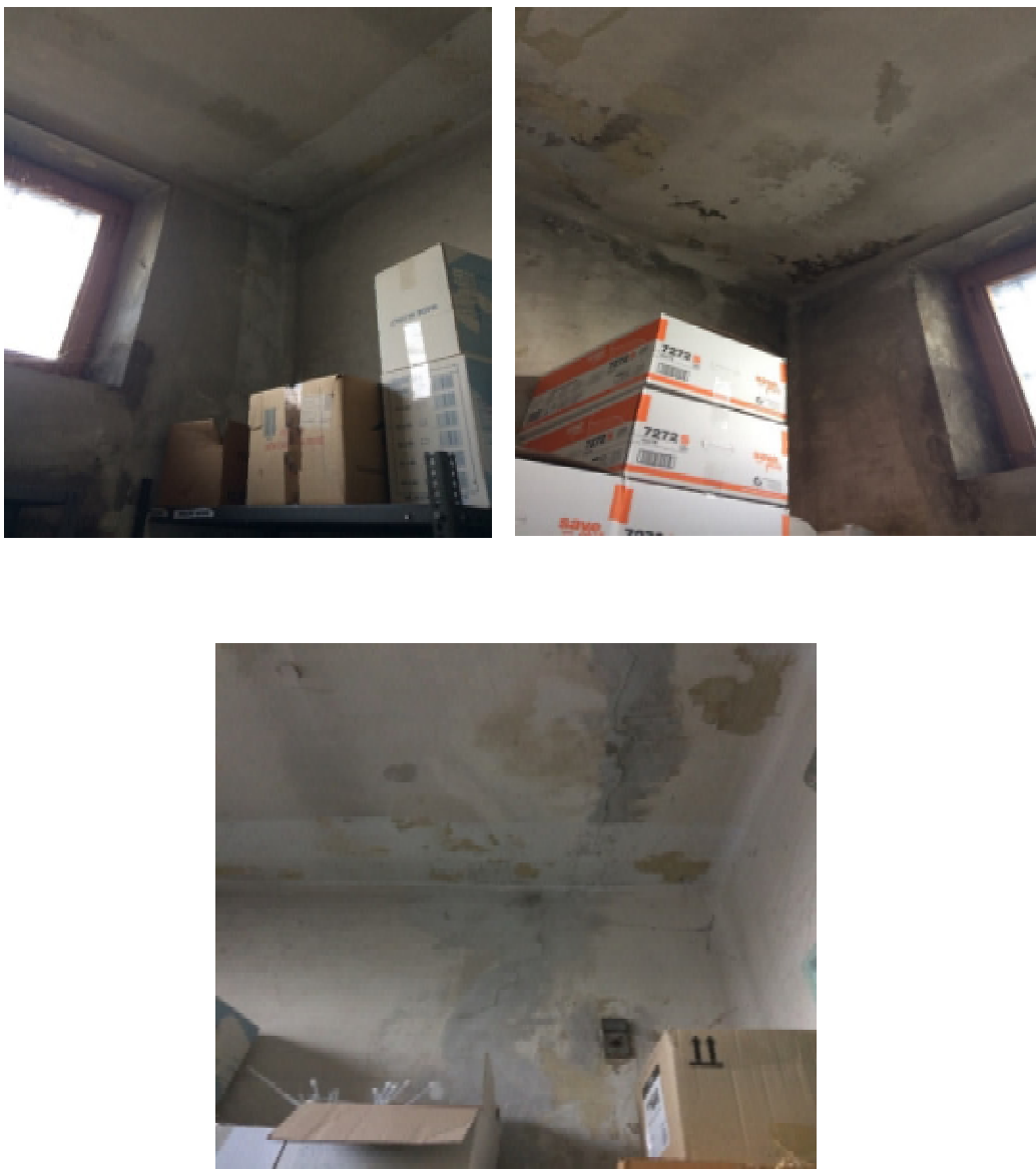
Figura 30 – Degrado nella zona interne delle scale
