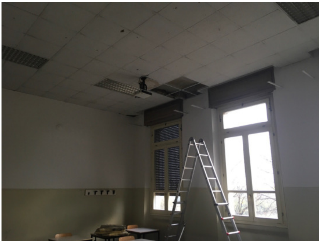
Figura 26 – Infiltrazioni di acqua al piano primo
