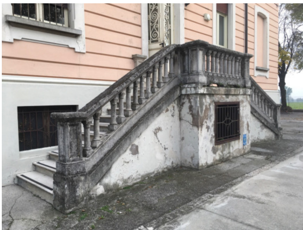
Figura 18 – Degrado della scala esterna 02
