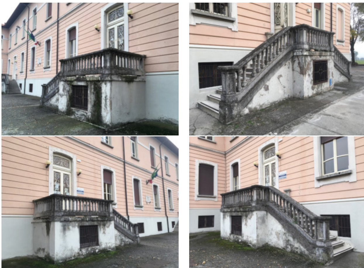
Figura 7 – Ammaloramento delle scale esterne
