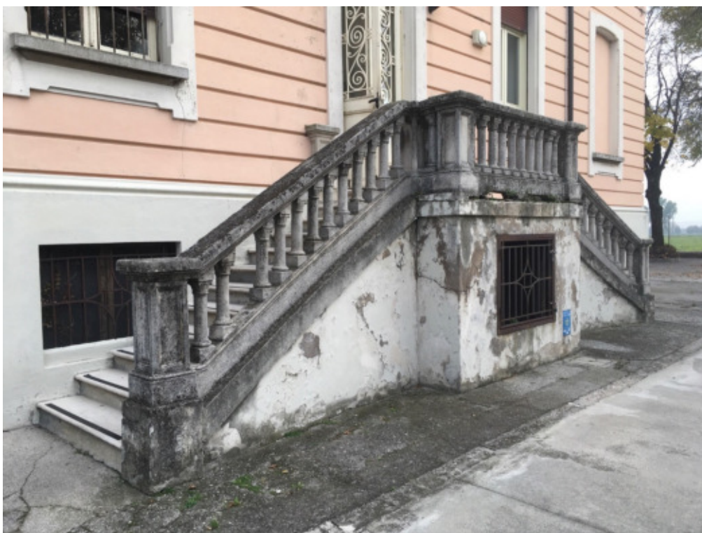
Figura36 – Degrado della scala esterna 02
