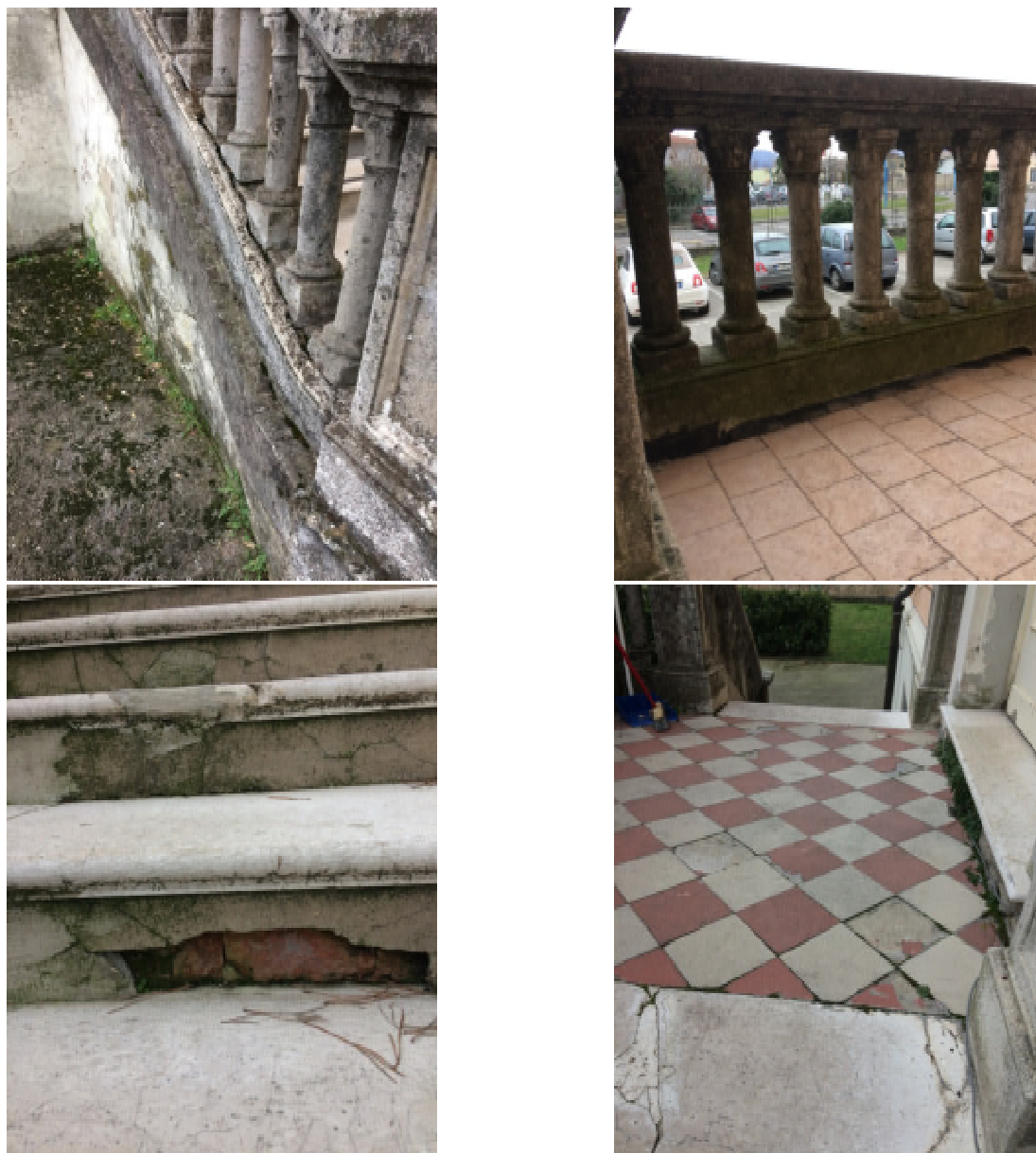
Figura 19 – Degrado generale delle scale esterne e visione della pavimentazione rimaneggiata (sopra a destra) e della pavimentazione originale (sotto a destra)
