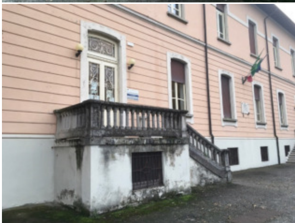
Figura 29 – Ammaloramento delle scale esterne
