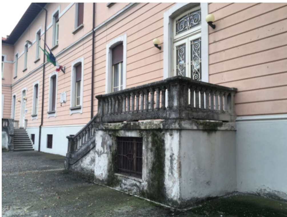
Figura 17 – Degrado della scala esterna 01
