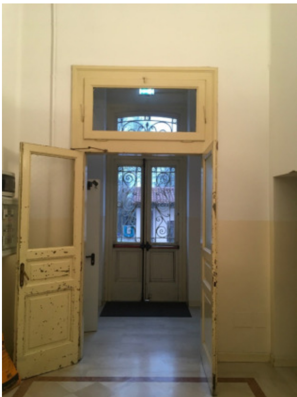
Figura 31 – Stato di conservazione dei serramenti interni principali
