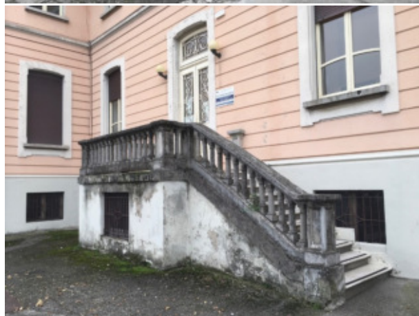
Figura 29 – Ammaloramento delle scale esterne
