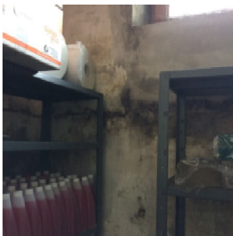
Figura 38 – Degrado interno alla scala esterna 02
