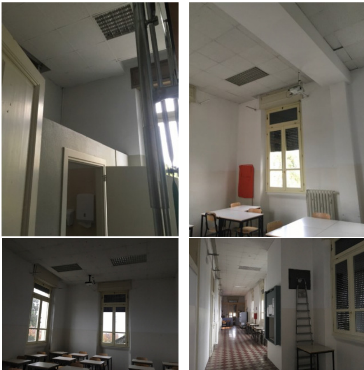
Figura 54 – Stato di conservazione dei controsoffitti
