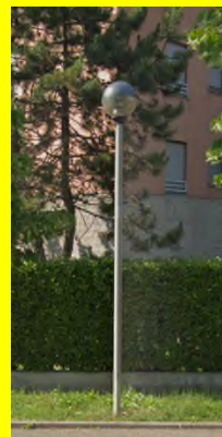
Globo non conforme LR 17/00
