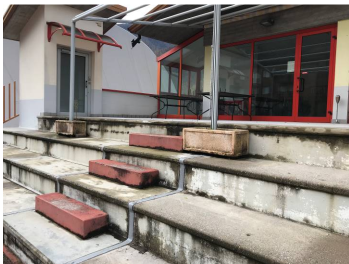
La tribuna prefabbricata in cemento armato
