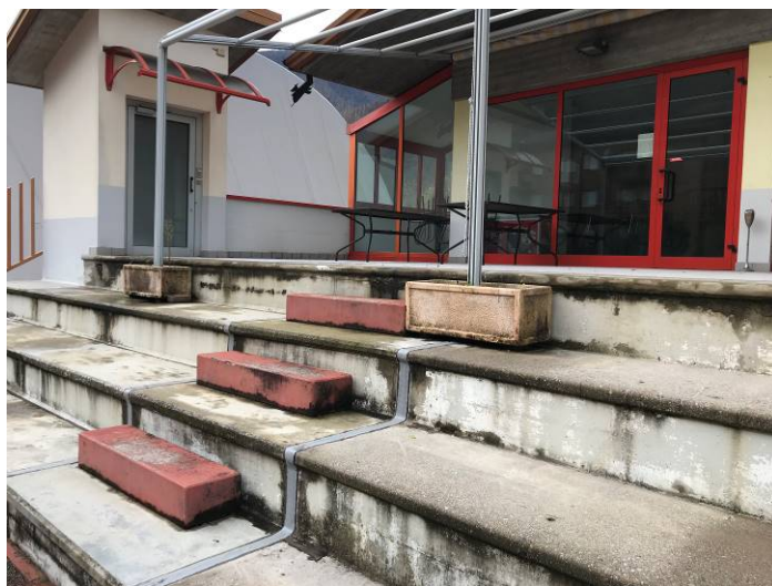
La tribuna prefabbricata in cemento armato
