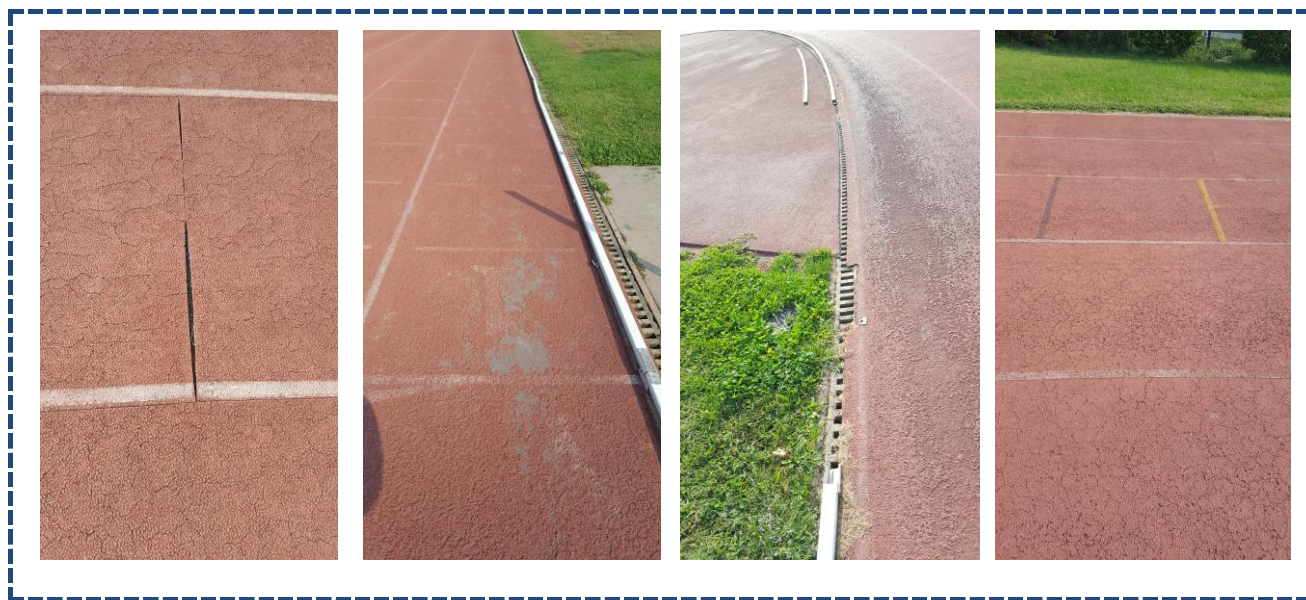
Figura 4 - Stato di fatto della pista di atletica leggera (particolare delle fessurazioni e usura manto)
