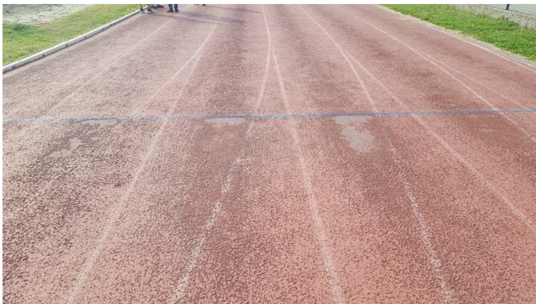
Figura 7 - dissesti e fessurazioni della pavimentazione attuale
