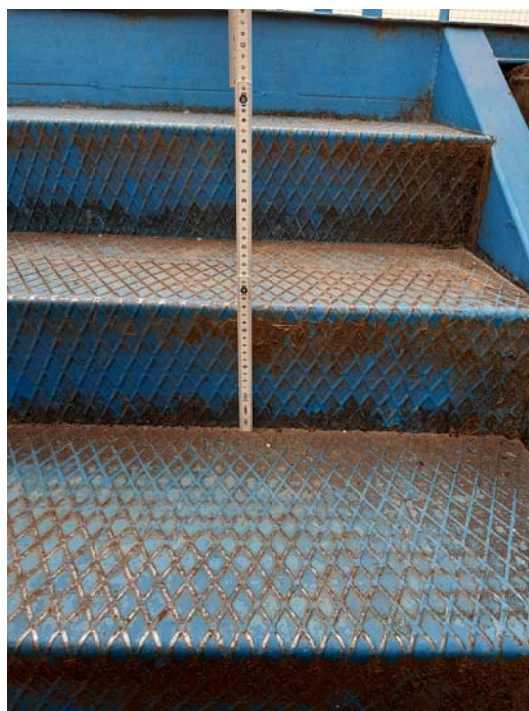
Figura 18 – Dettagli dell'attuale scala d'accesso alle tribune che verrà sostituita con una nuova rampa di accesso per l'abbattimento delle barriere architettoniche
