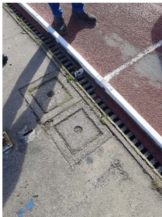
Figura 11 – Pozzetti d'ispezione che dovranno essere sostituiti a seguito dell'installazione del nuovo portale
