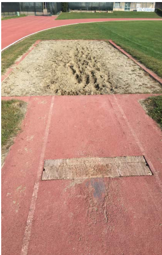
Figura 10 - Stato di fatto della pedana per il salto in lungo - dissesti nella pavimentazione
