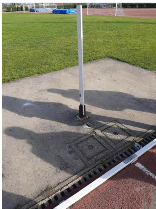
Figura 11 – Pozzetti d'ispezione che dovranno essere sostituiti a seguito dell'installazione del nuovo portale
