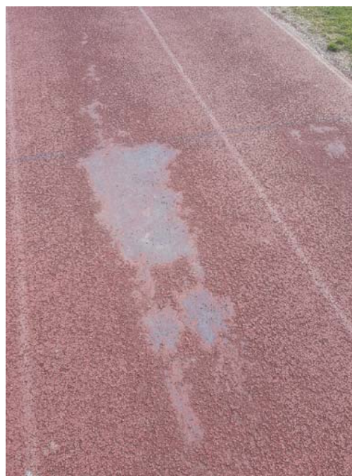
Figura 8 - dissesti e fessurazioni della pavimentazione attuale
