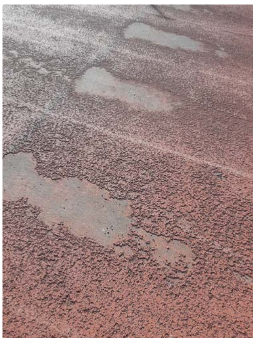
Figura 8 - dissesti e fessurazioni della pavimentazione attuale
