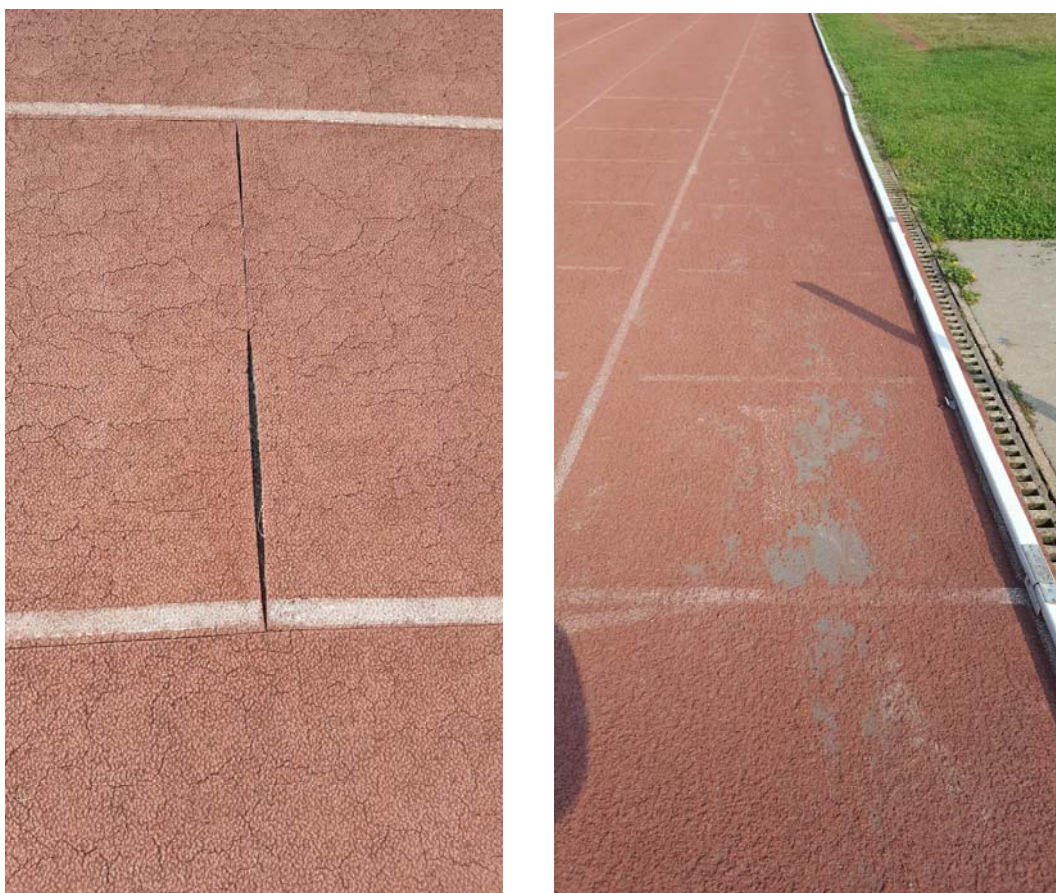
Figura 6 - dissesti e fessurazioni della pavimentazione attuale
