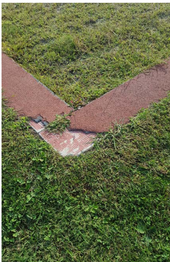
Figura 10 - Stato di fatto della pedana per il salto in lungo - dissesti nella pavimentazione
