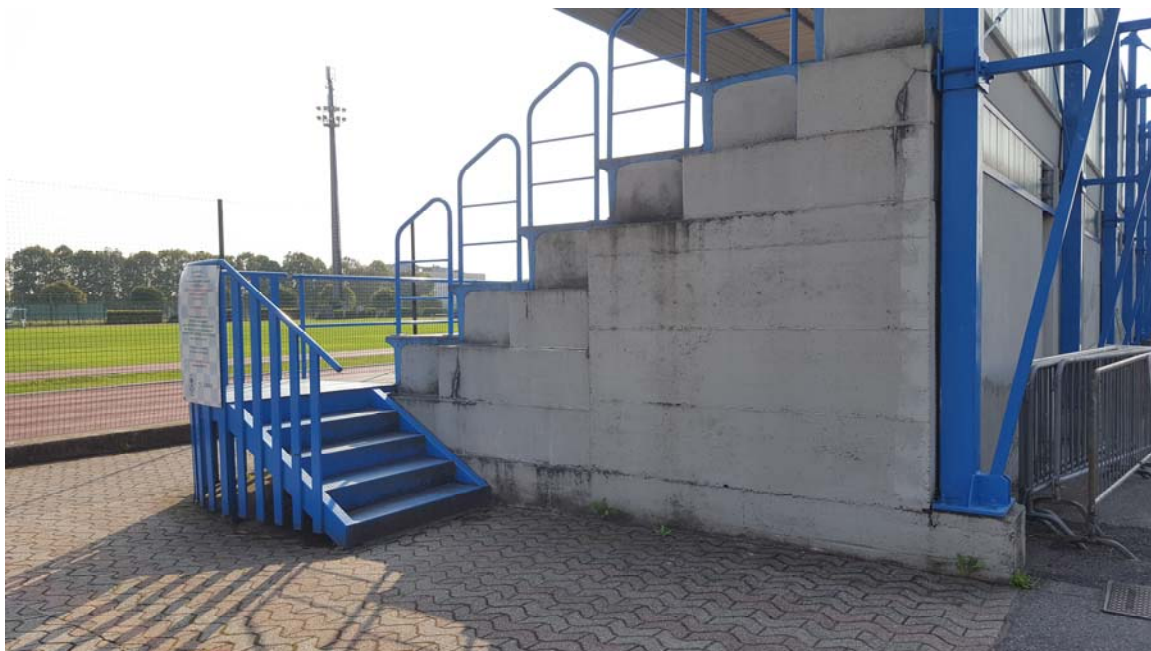
Figura 19 - scala di accesso alla tribuna che sarà sostituita con una rampa di accesso anche per persone diversamente abili
