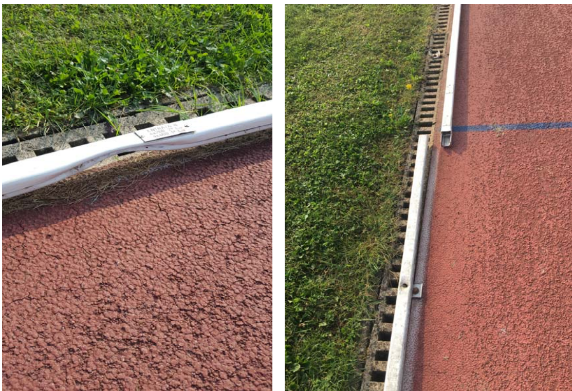
Figura 14 – Dettagli del cordolo da sostituire
