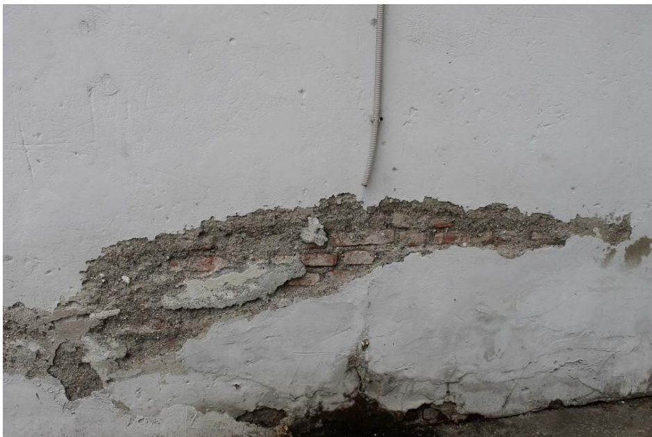
Muratura in mattoni dell'edificio spogliato addossato alla palestra
