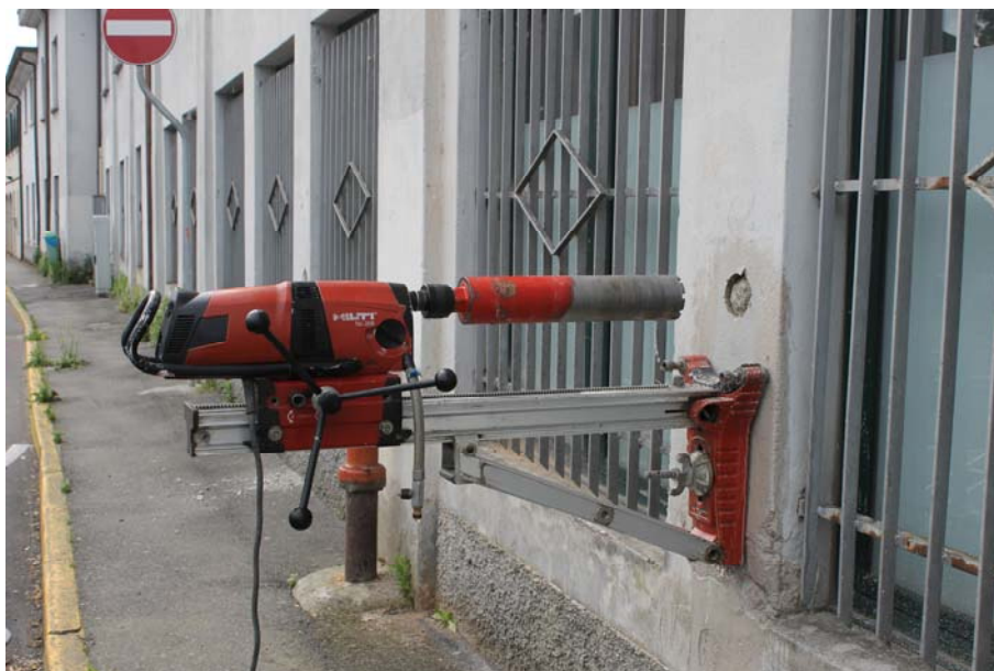
Carotaggio pilastro in calcestruzzo
