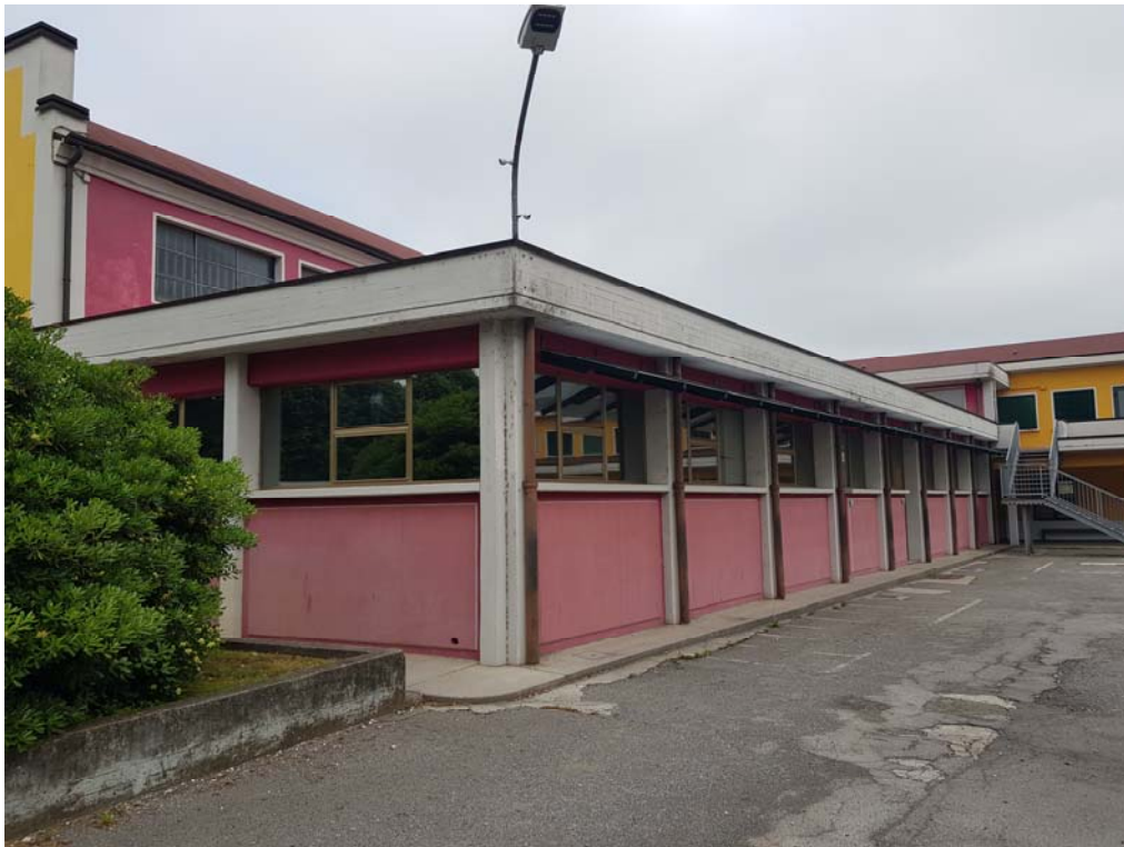
Fig. 3 pilastri tozzi per la presenza dei setti in c.a.
