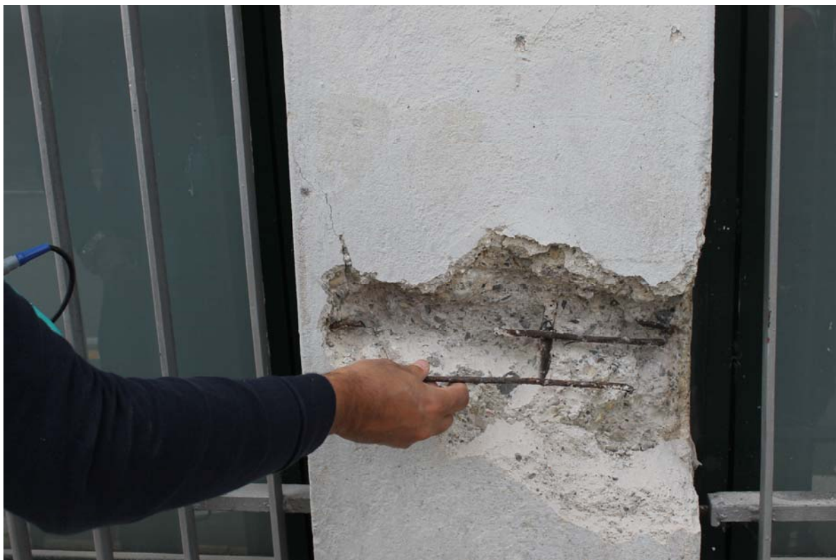
Asportazione della barra di armatura indagata in laboratorio
