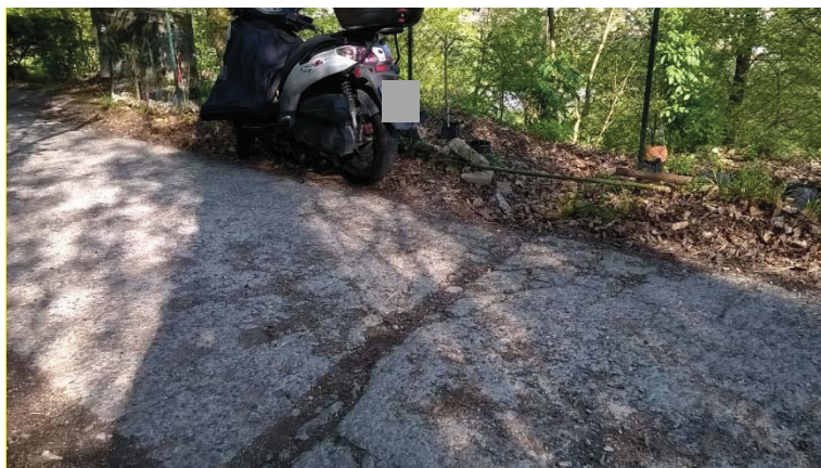
Figura 4: vista di una canaletta trasversale posta alla quota di circa 310 m s.m. che drena le acque di deflusso della strada verso il pendio sottostante concentrandone lo scorrimento sul versante.
