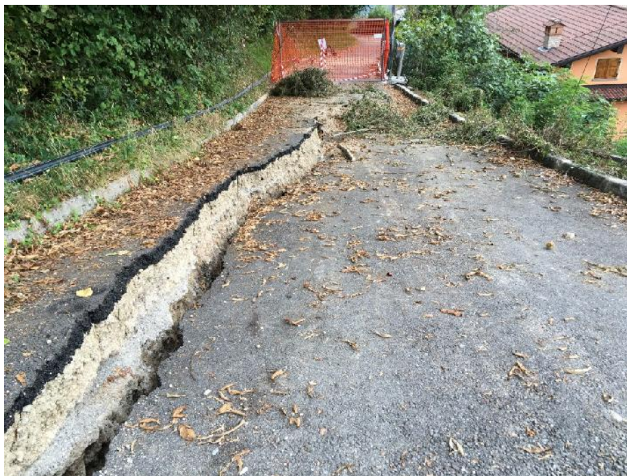
Via della Parrocchia dal tornante: ben evidenti le fratture di trazione – il fianco di frana sembra coincidere con il limite di proprietà dell'abitazione a valle di via Parrocchia 28.09.2018
