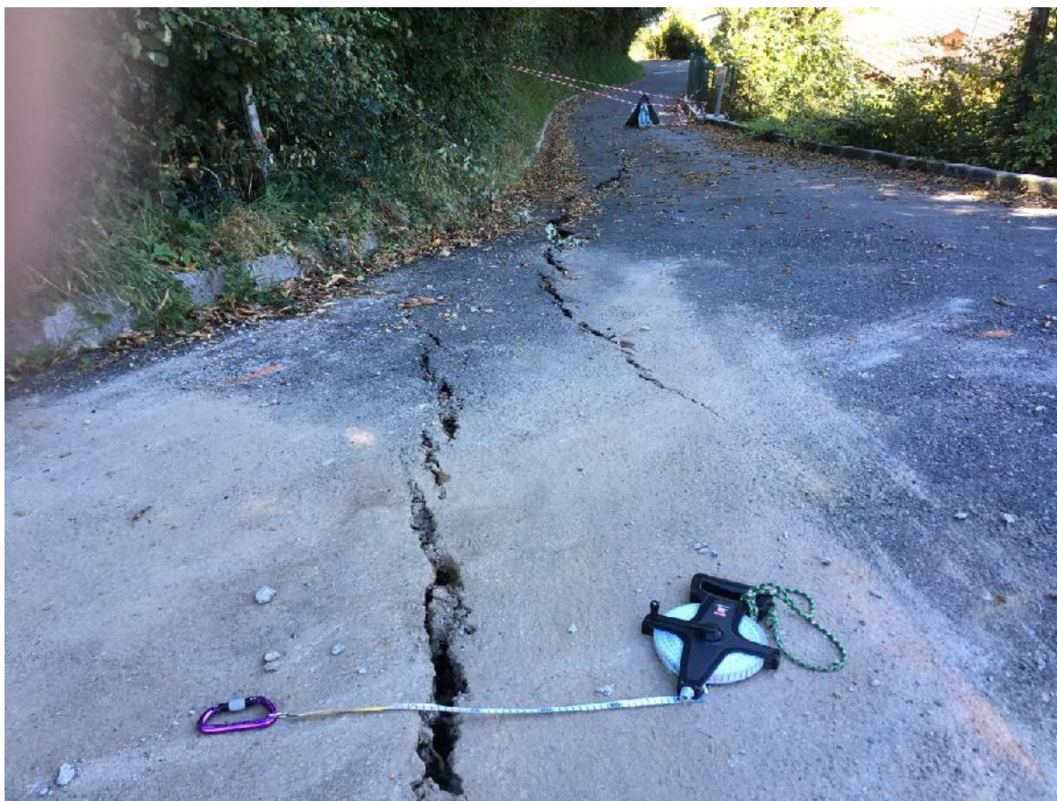
Via della Parrocchia dal tornante: ben evidenti le fratture di trazione – il fianco di frana sembra coincidere con il limite di proprietà dell'abitazione a valle di via Parrocchia 28.09.2018
