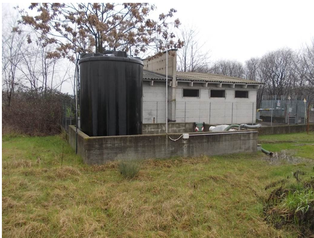
Figura 3.4 – Cisterna di stoccaggio sistema MISE P&S
