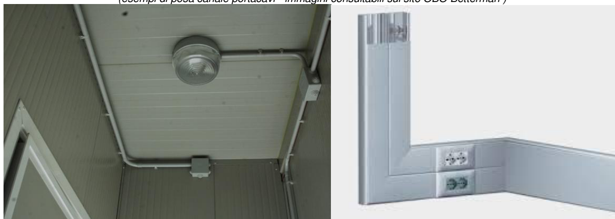
(esempi di posa tubazioni plastiche a vista e canale portacavi in materiale plastico )
