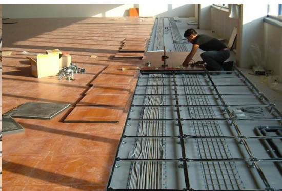
(esempio impianti a vista nel pavimento galleggiante)
