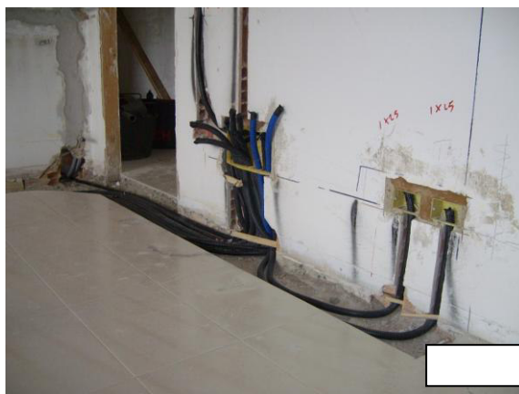
(esempio di tubazioni sottotraccia)
