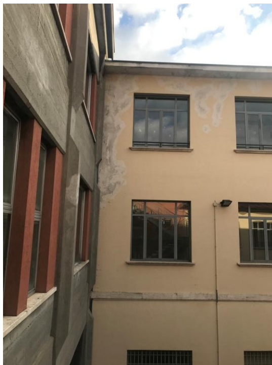
FACCIATA CORTE INTERNA CON EVIDENTI INFILTRAZIONI D'ACQUA
