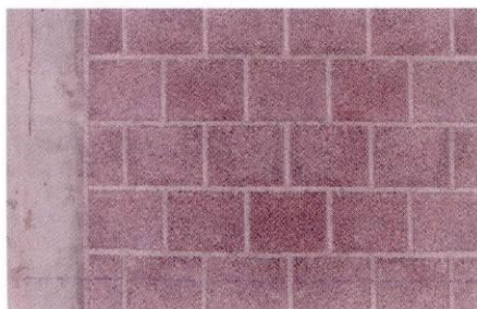
Giunto tra pilastro e muratura.
