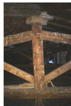
PERDITA DELLO SCHEMA "A CAPRIATA"
