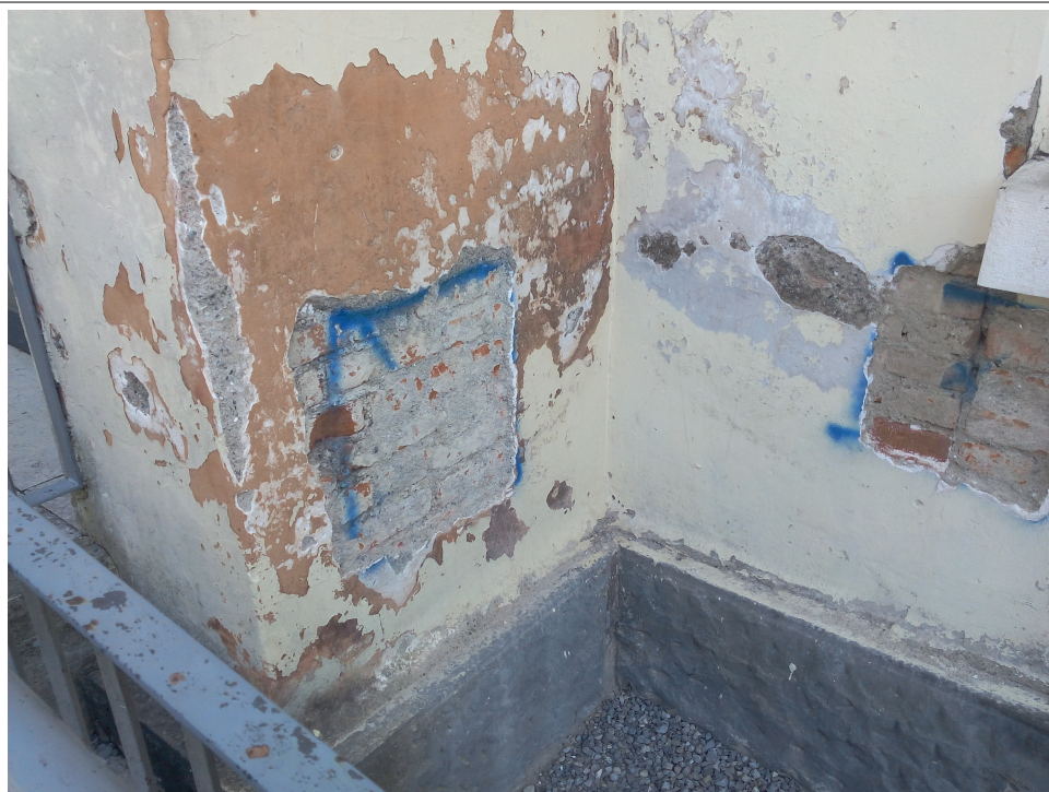
Figura 1.6: Rilievo delle murature portanti
