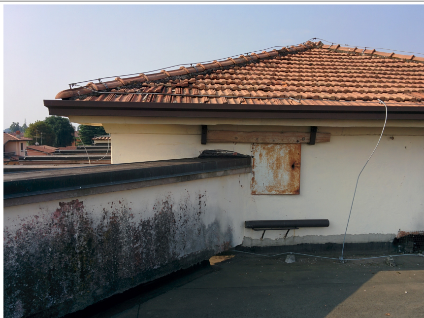
Figura 1.8: Rilievo della copertura – tegoli alla “marsigliese”
