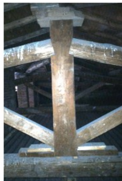
PERDITA DELLO SCHEMA "A CAPRIATA"
