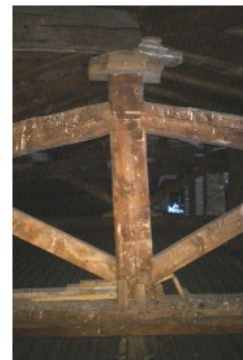
PERDITA DELLO SCHEMA "A CAPRIATA"
