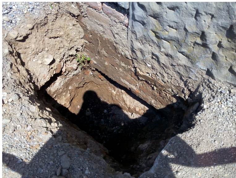
Figura 1.7: Rilievo delle fondazioni dell'edificio in muratura
