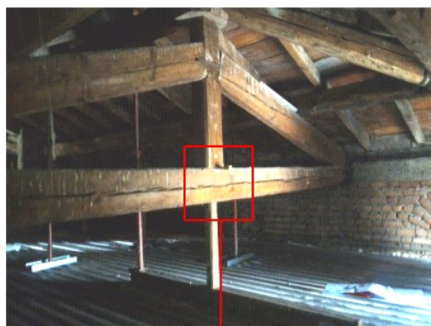
PERDITA DELLO SCHEMA "A CAPRIATA"
