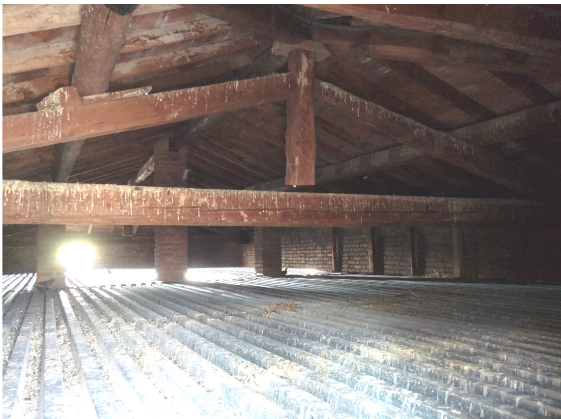
Figura 19: orditura lignea della copertura
