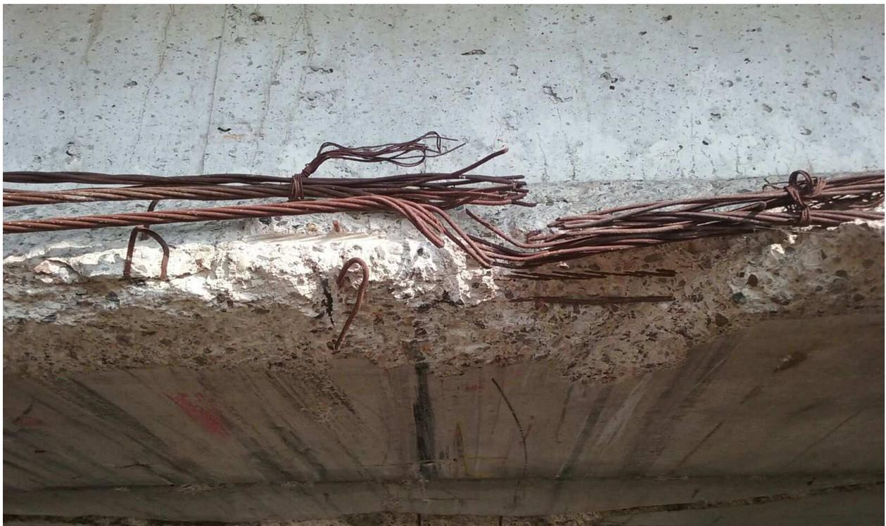
Figure 2 e 3. – Alcuni particolari di trefoli interrotti e corrosi.
