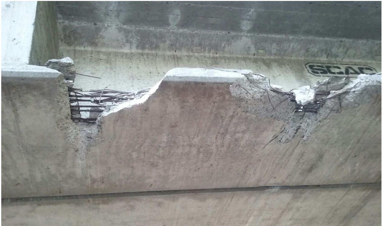
Figura 1 – Particolare dell'ultima trave dell'impalcato in lato nord, nelle condizioni rilevate dopo l'incidente del 25/9/2017.
