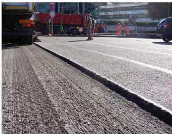
Superficie del piano stradale dopo la fresatura.
