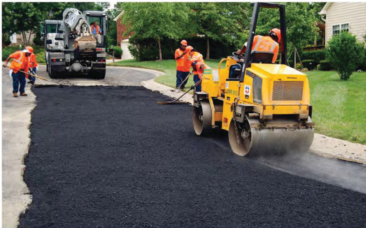
Fase di compattazione del conglomerato bituminoso mediante rullo compattatore.
