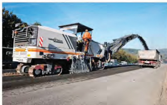
Operazione di fresatura realizzata da una macchina fresatrice e caricamento del materiale asportato su autocarro.
