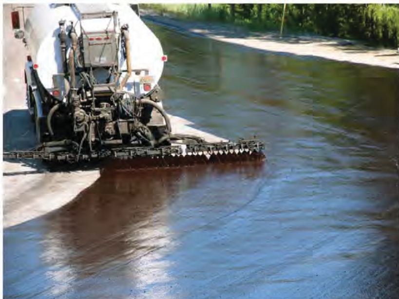
Applicazione a caldo mediante diffusore di emulsione bituminosa.
