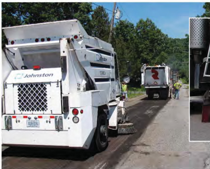
Superficie del piano stradale dopo la fresatura.
