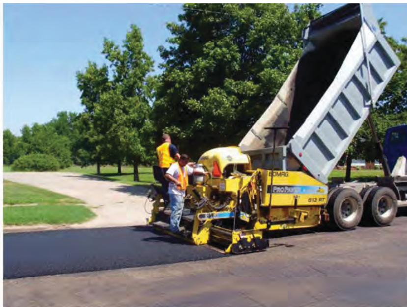
Applicazione a caldo mediante diffusore di emulsione bituminosa.
