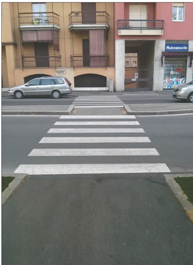
Figura 3 - Rampa di raccordo tra marciapiede e attraversamento pedonale.
