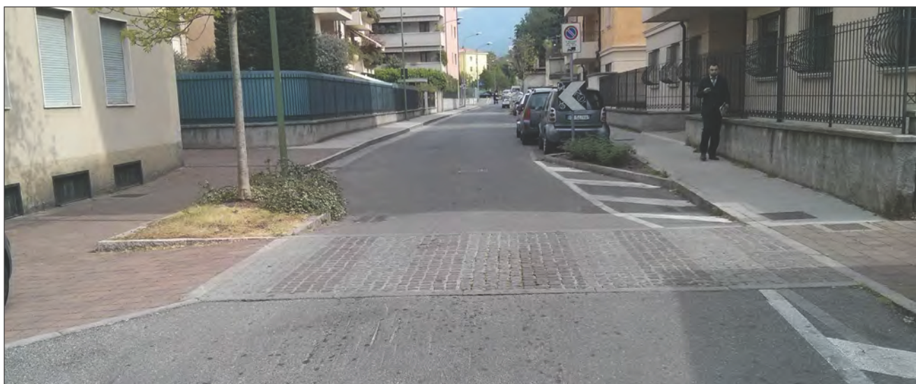
Figura 9 - Ampliamento del marciapiede in corrispondenza dell'attraversamento pedonale che crea un effetto chicane, riducendo la larghezza della carreggiata. L'utilizzo di materiali differenziati dovrebbe migliorare la percepibilità della zona di conflitto; in questo caso, tuttavia, lo scarso contrasto cromatico attenua la visibilità della zebra.
