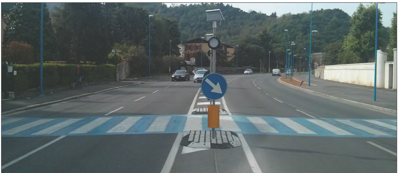
Figura 17 - Isola salvagente provvisoria realizzata con elementi recuperabili e riutilizzabili. Lo sfondo verniciato non è ammesso dalla normativa vigente.
