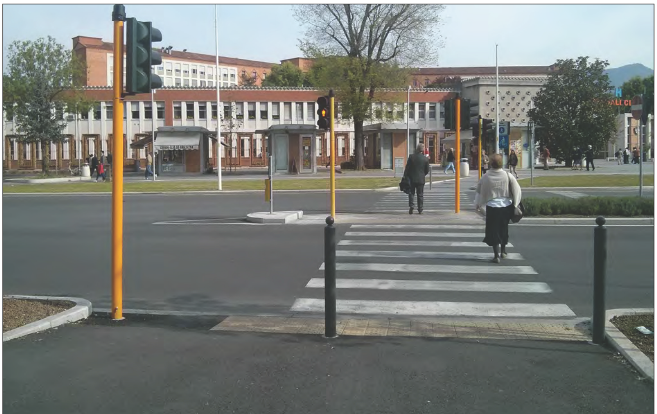
Figura 21 - Attraversamento pedonale con segnaletica tattile di attenzione. La larghezza del segnale di attenzione non deve eccedere quella della zebra, come in questo caso.
