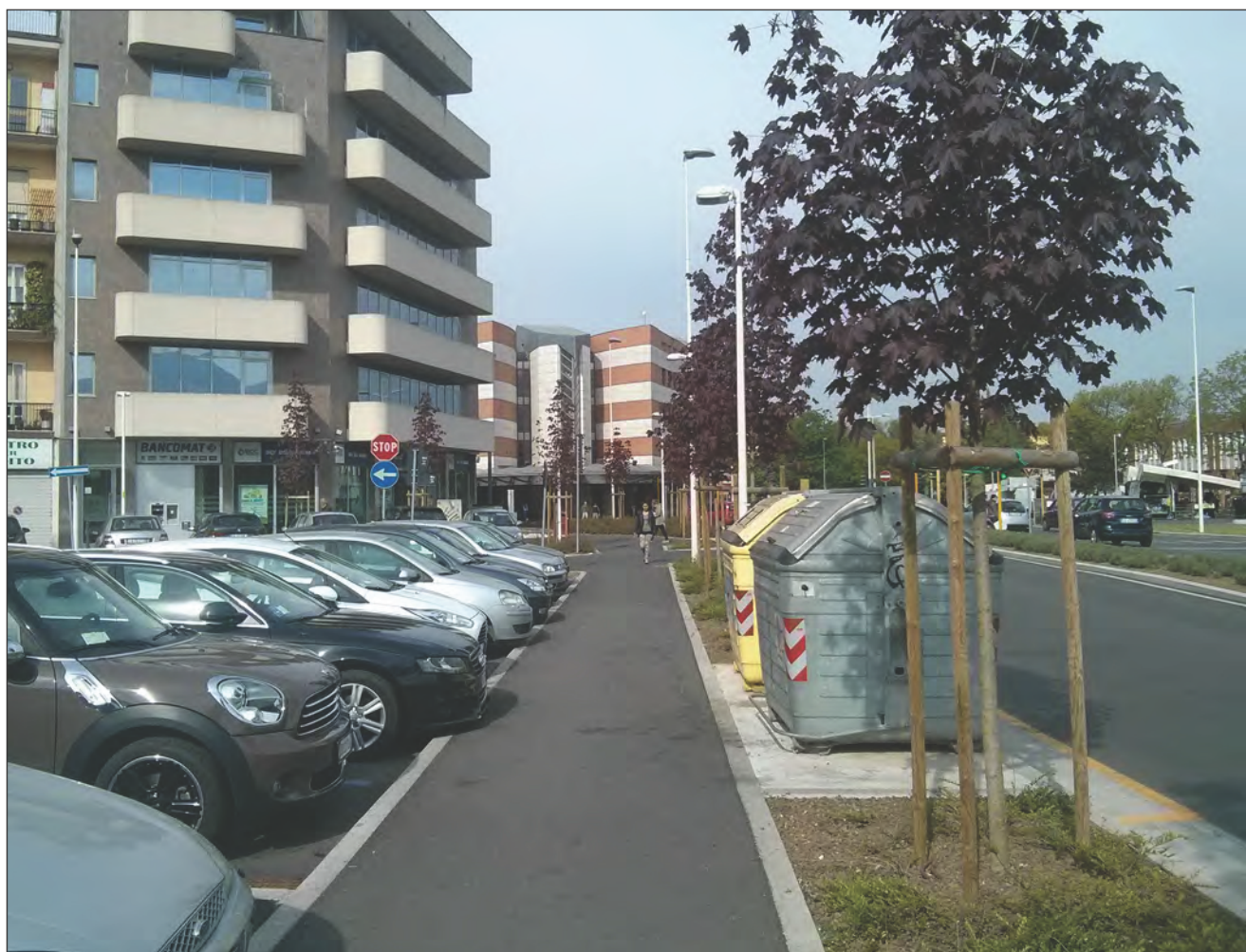
Figura 2 - Percorso pedonale con andamento regolare e sezione costante. Gli elementi di arredo sono sistemati in una fascia dedicata.
