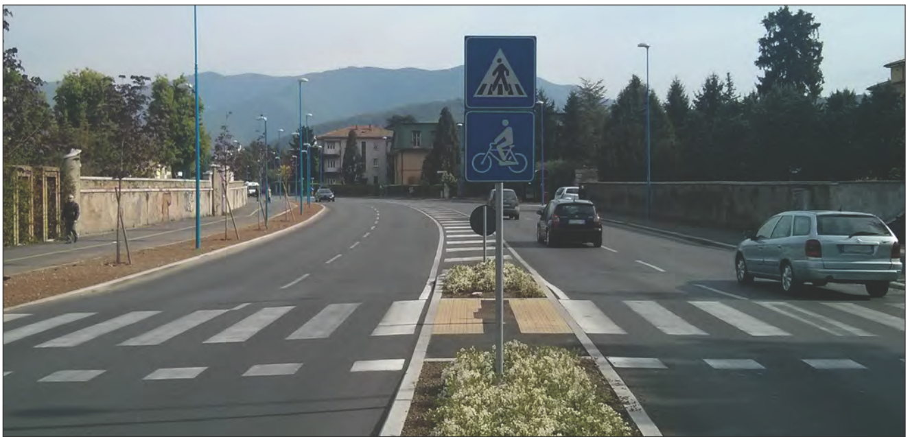
Figura 16 - Particolare della segnaletica orizzontale e verticale dell'attraversamento ciclabile adiacente a quello pedonale.
