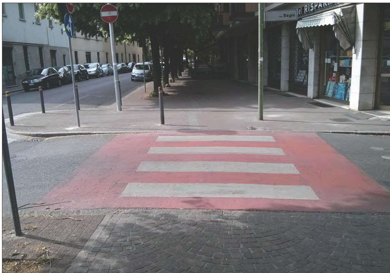
Figura 19 - Attraversamento pedonale rialzato. La segnaletica orizzontale, realizzata con vernice bi-componente a freddo spatolato, non è corretta in quanto la verniciatura dello sfondo non è ammessa.
