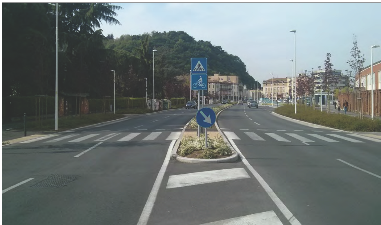
Figura 14 - Particolare dell'isola salvagente e della segnaletica orizzontale di attestamento. Si evidenzia la mancanza del delineatore speciale di ostacolo, previsto dal codice della strada per segnalare l'isola centrale.
