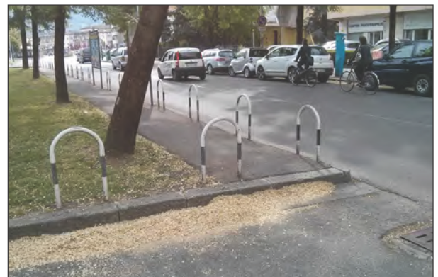
Figura 5 - Il gradino costituisce una barriera architettonica.
