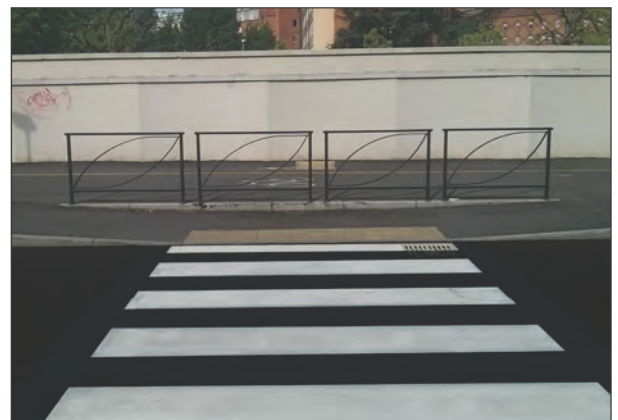
Figura 4 - Soluzione con due rampe di raccordo tra marciapiede e piano stradale e sistemi di protezione.
